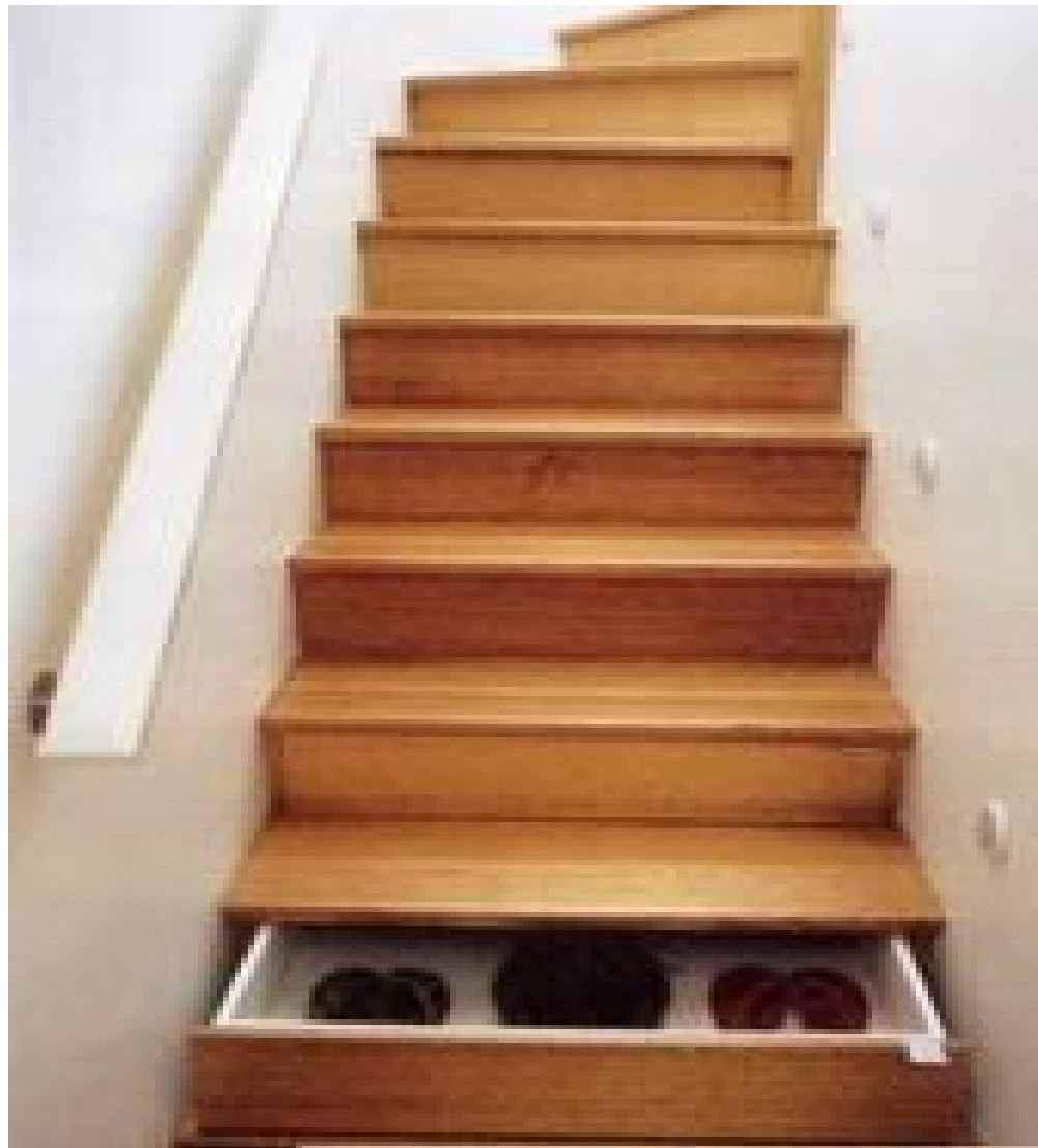
Escaliers à tiroirs
